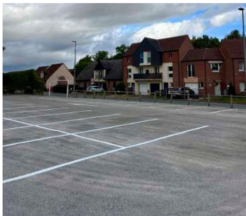
Rénovation du parking du Bastion Richelieu
