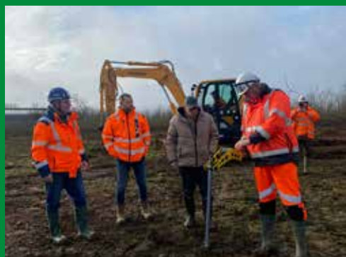
Travaux du contournement Sud-Est
